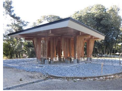
府営公園の木造休憩施設
