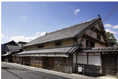
古民家を宿泊施設等にコンバージョン ※
