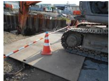
汚染土壌掘削工事の現地確認状況
