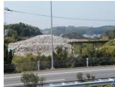
産業廃棄物の不適正処理現場(不適正保管)
