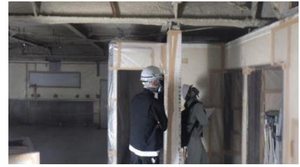
解体現場の立入調査
