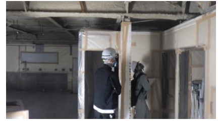
解体現場の立入調査
