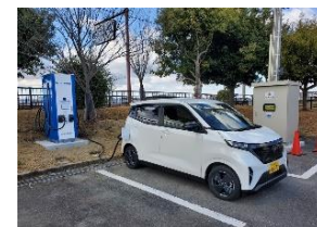
府有施設への充電設備の設置
