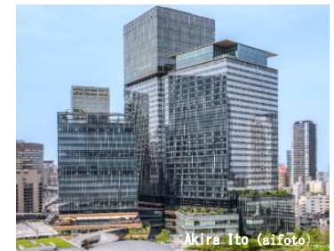
“涼”デザイン建築賞 -ZEB Style-（令和7年度） グラングリーン大阪 南館
