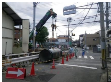
老朽化した水道管路の更新・耐震化
