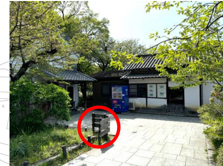
誘導サインAタイプの設置状況 (赤丸)
