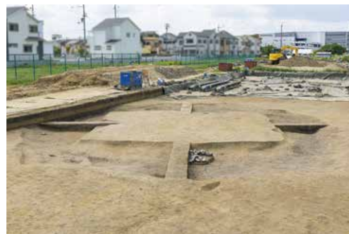
写真2 古墳2 周溝掘削状況（南東から撮影）
