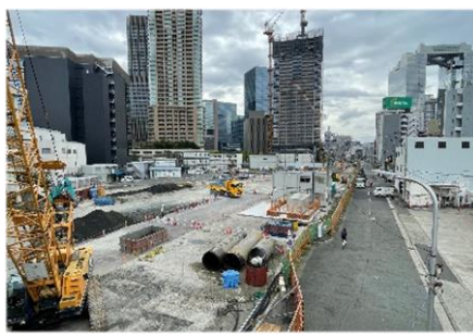
【国道176号以北の工事状況】
