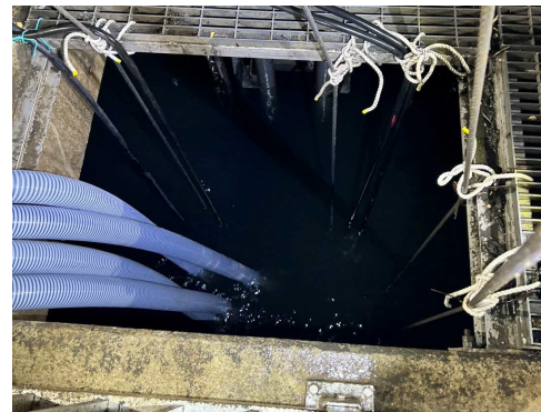
仮設ポンプによる排水状況
