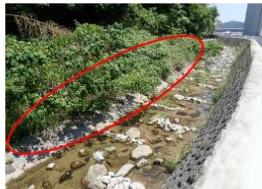
緩傾斜護岸の造成 (生物の避難路の設置)
