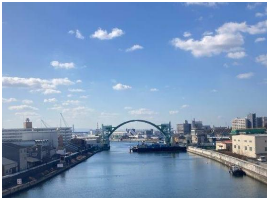
現在の木津川水門
