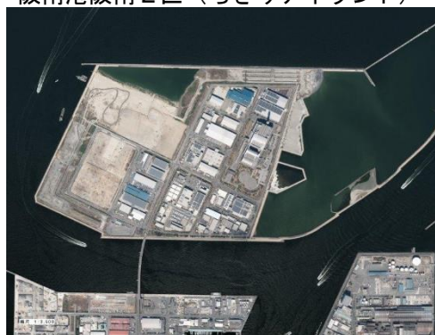
阪南港阪南2区（ちきりアイランド）
