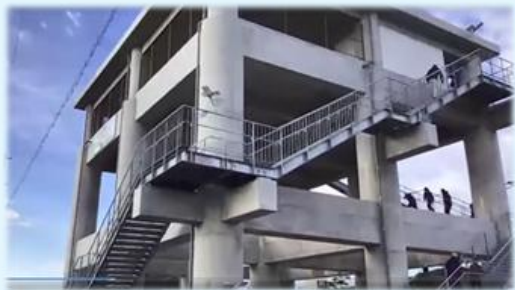
津波避難タワー整備の支援 (志摩市)
