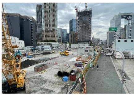
【国道176号以北の工事状況】
