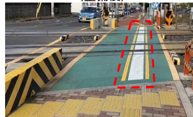
【踏切内の誘導用ブロックの設置】 （泉南市）
