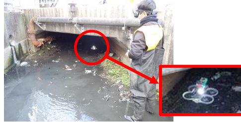
ドローンを活用した橋梁点検
