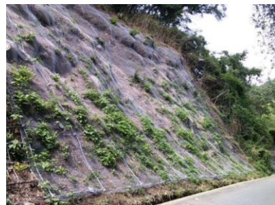
【道路法面对策】
