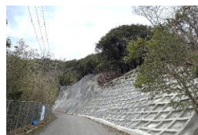
〔道路法面对策〕
