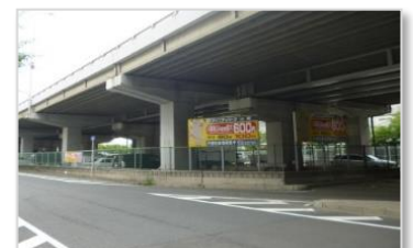
国道423号 江坂高架橋下（吹田市）
