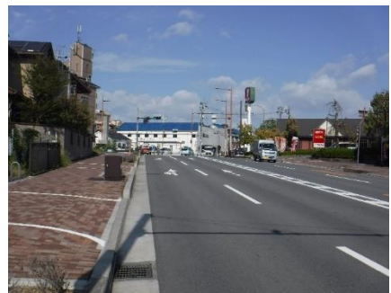
【無電柱化の事例】国道170号（羽曳野市）
