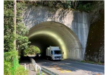
走行型計測車を活用したトンネル点検
