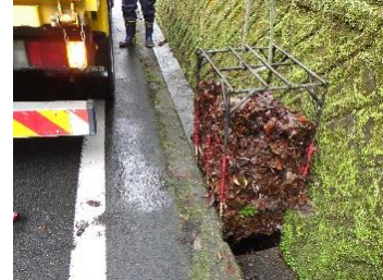
道路施設の清掃
