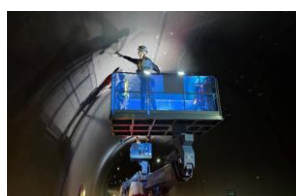
〔トンネル点検〕
