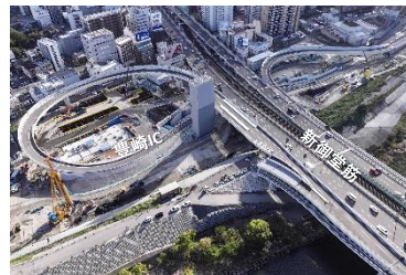
淀川左岸線 2期・延伸部 ((仮称)豊崎IC)
