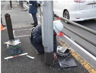
照明柱の非破壊調査
