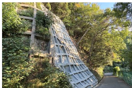
【道路法面对策】
