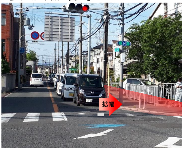
【交差点改良事例（車線の拡幅）】 玉井交差点（東大阪市）
