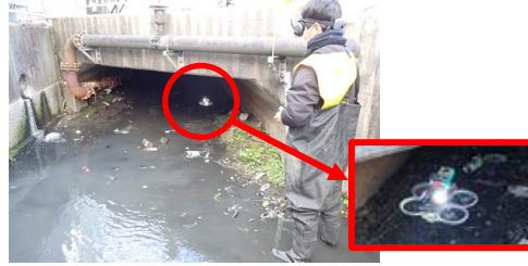
ドローンを活用した橋梁点検
