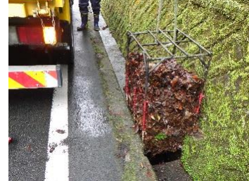
道路施設の清掃
