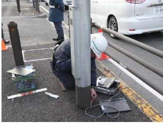
照明柱の非破壊調査
