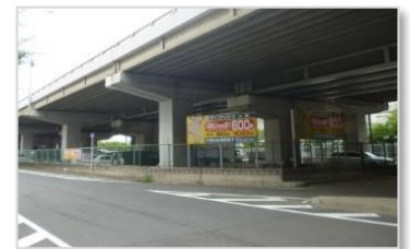
国道423号 江坂高架橋下（吹田市）
