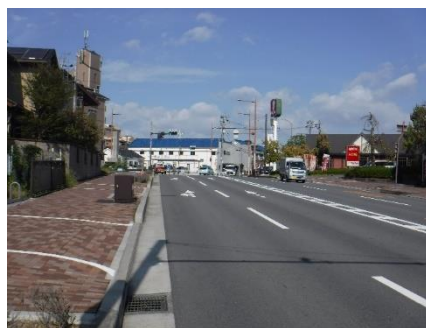
【無電柱化の事例】国道170号（羽曳野市）
