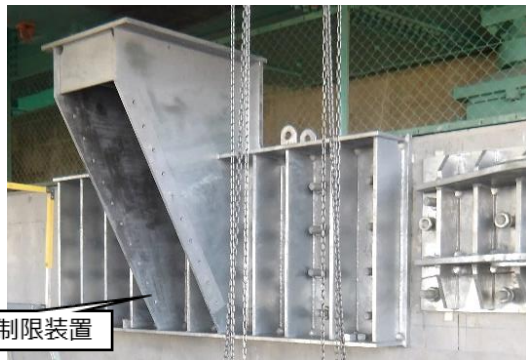
【変位制限装置の設置】
