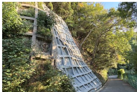
【道路法面对策】
