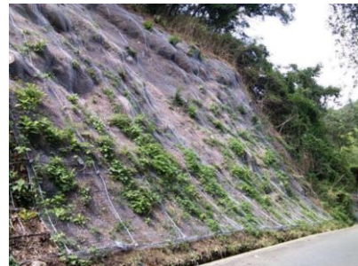
【道路法面对策】
