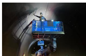
〔トンネル点検〕
