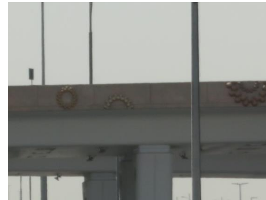
道路橋の高欄（ロゴマーク）
