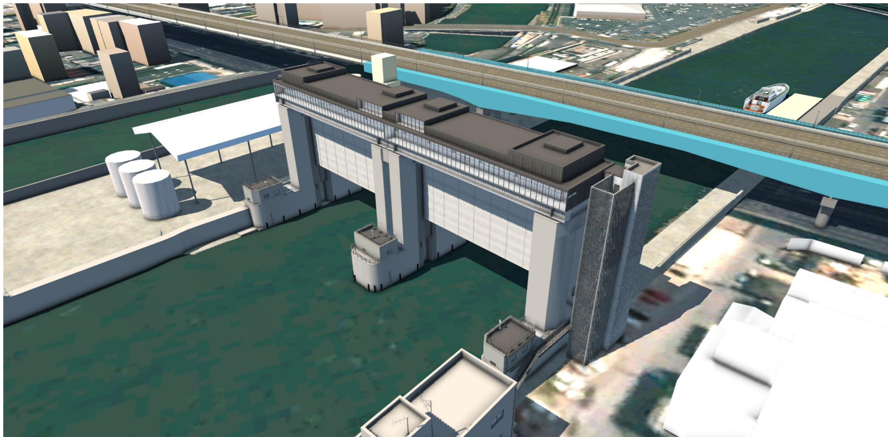
全体鳥瞰_下流側
