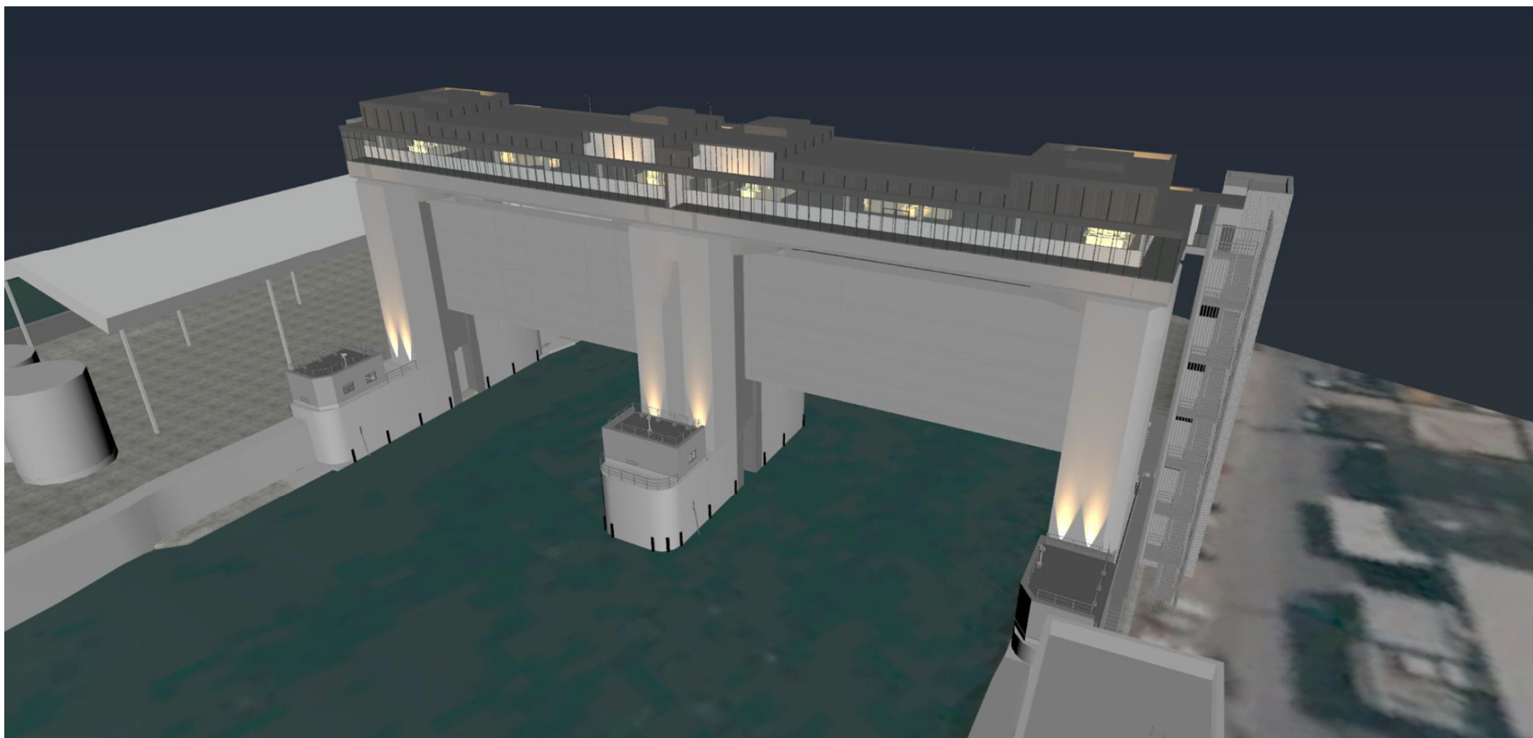
オレンジ系_下流左岸側_鳥瞰
