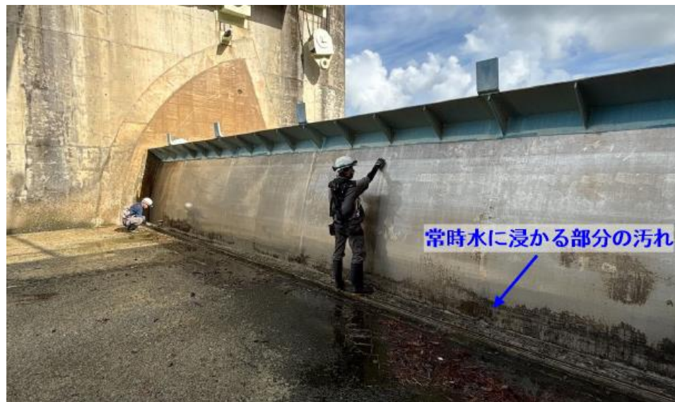
福地ダム(46年経過)
