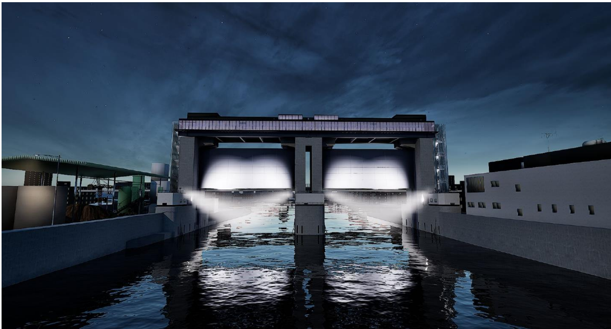
管理用照明(上屋照明のみ無し)
