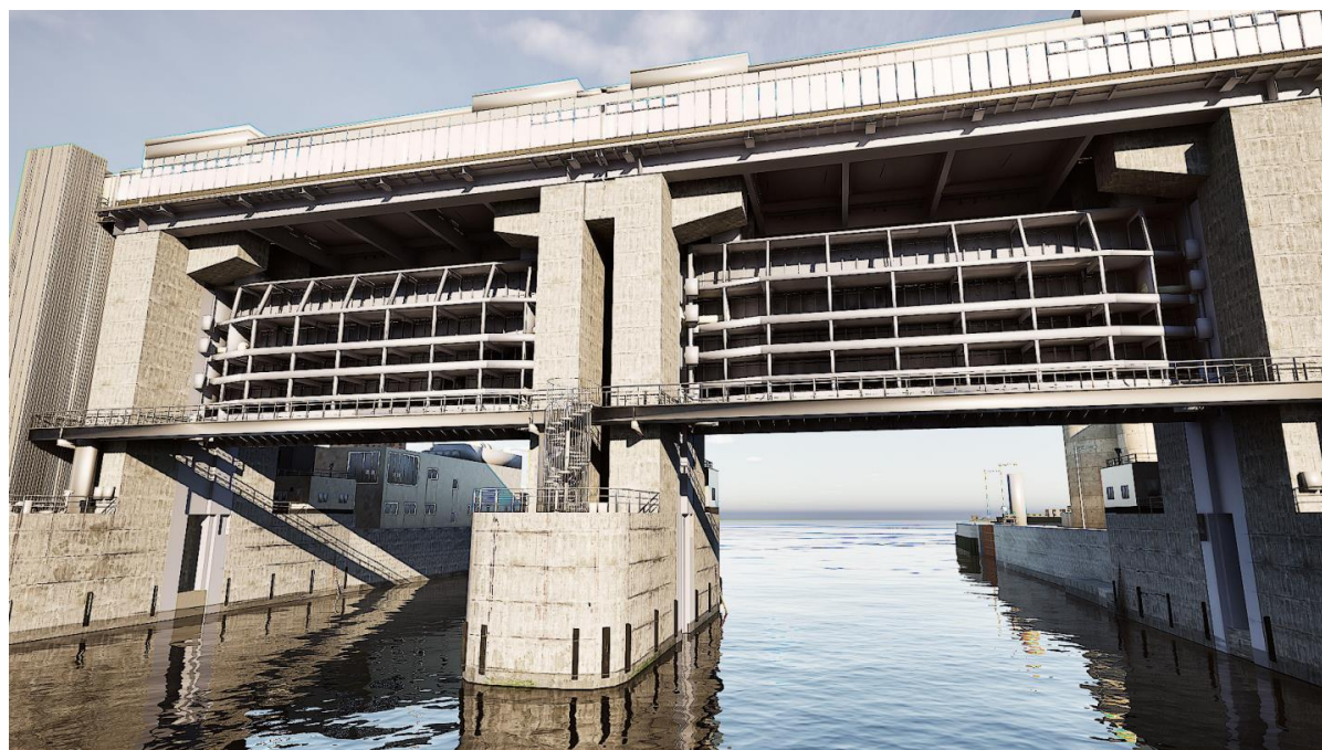
劣化後 (50年程度経過)
