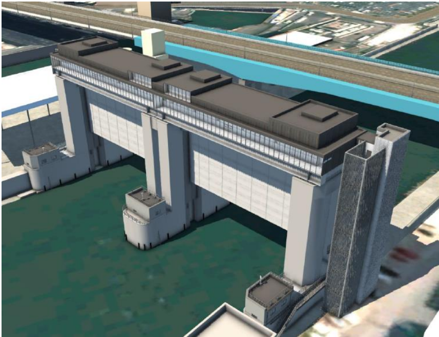
全体俯瞰 下流側
