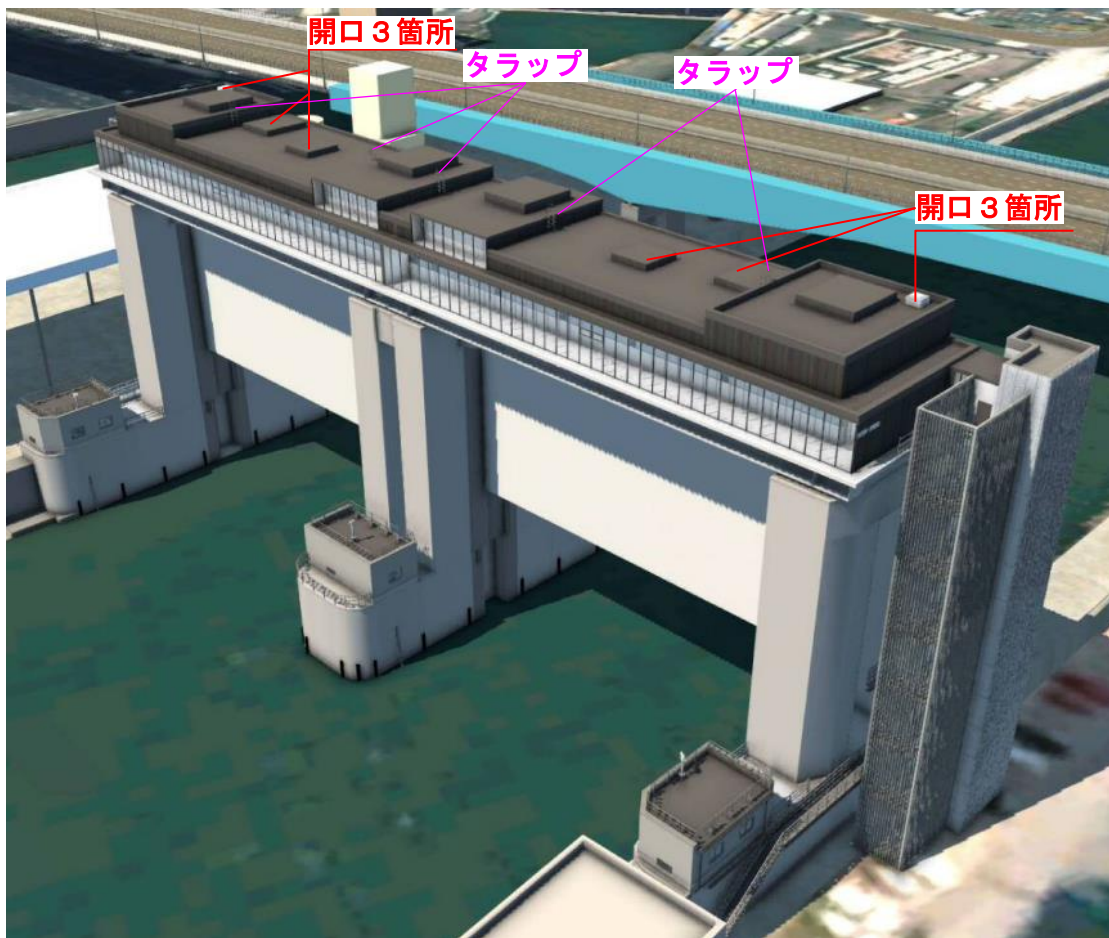
全体俯瞰 下流側 (修正案)
