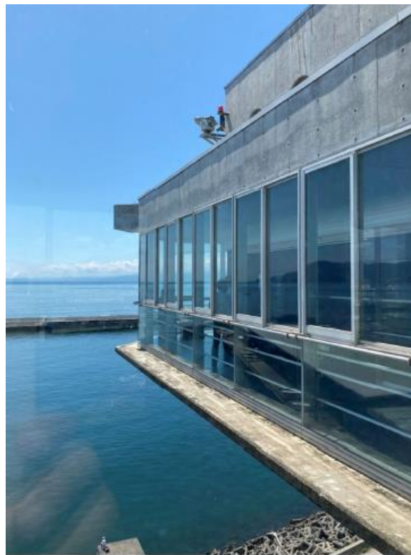
（参考）びゅうお水門（静岡県） キャットウォーク
