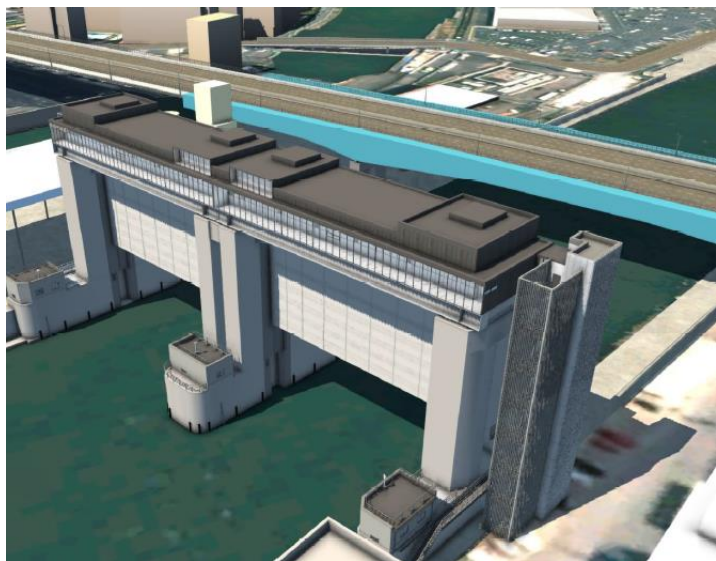
全体俯瞰 下流側 (第2回デザイン会議時点)
