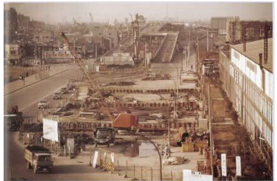
工事中の国道43号（弁天町駅付近）
