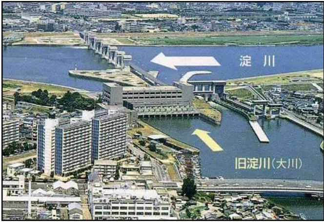
毛馬排水機場
