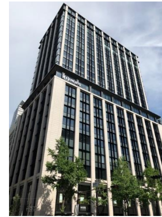
③三菱UFJ銀行 高さ: 101m (地上21階/地下3階) 竣工: 2018.8開業 容積: 1,400% 用途: オフィス(銀行)
