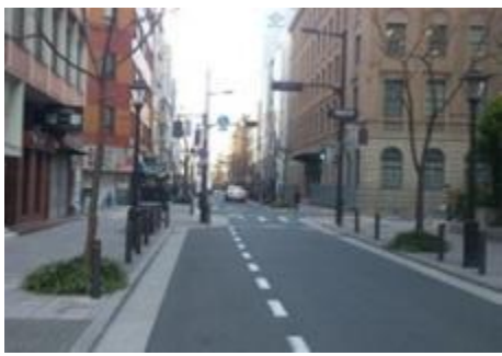
<整備された三休橋筋>
