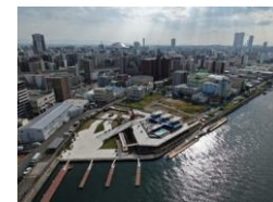
中之島GATEサウスピア
