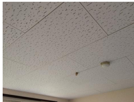
天井：岩綿吸音板
