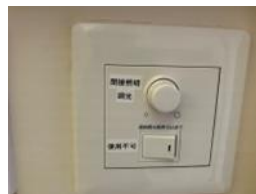
照明(調光) 上のつまみ左右に回すと明るさが変わります
