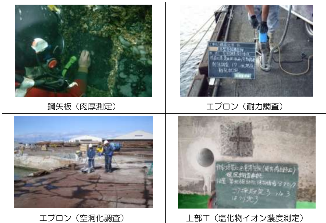
写真 2.2-2 二次点検（専門家）の現状
