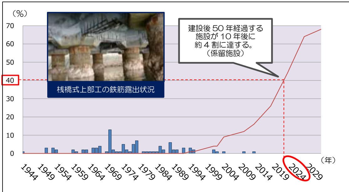
図 2.1-2 港湾施設（係留施設）の経過年数
