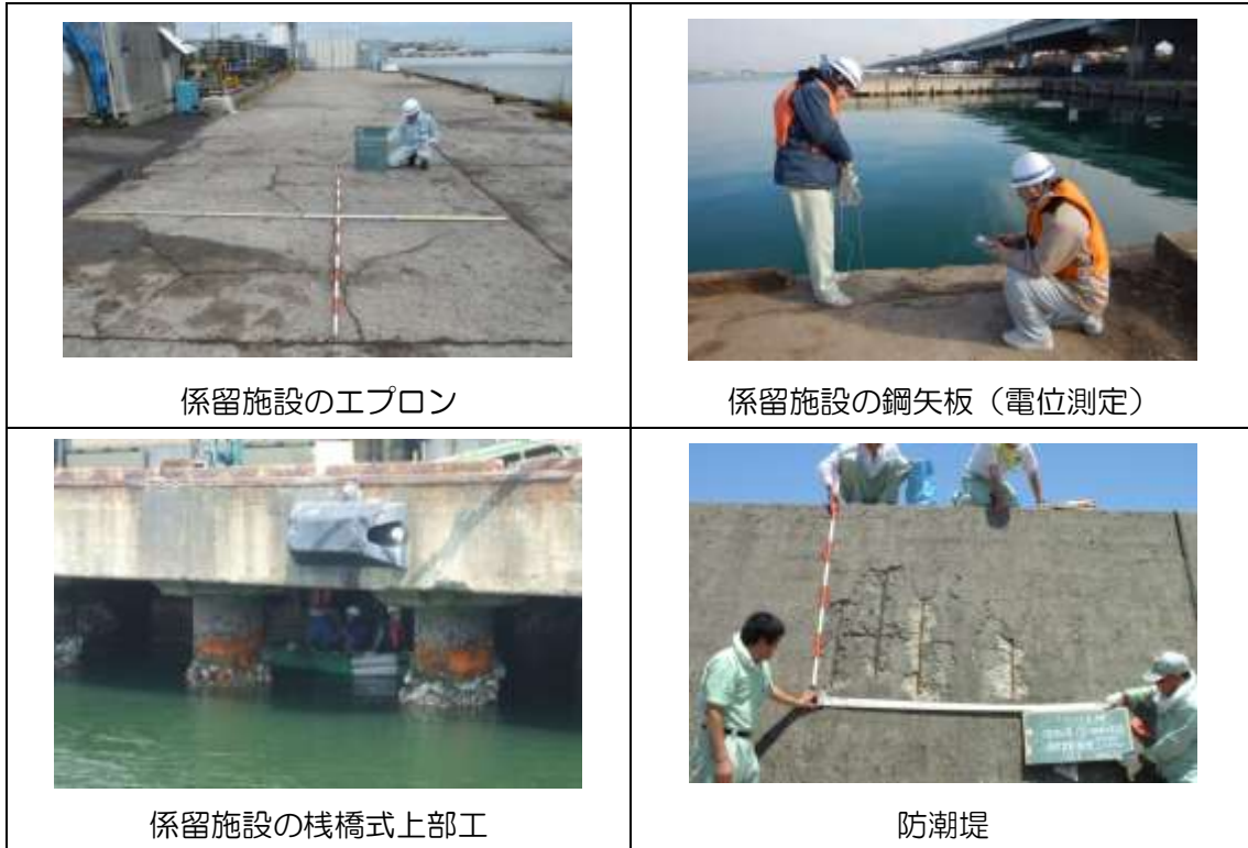
写真 2.2-1 一次点検（職員）の現状
