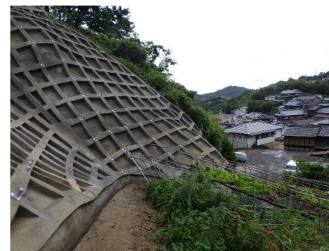
急傾斜地崩壊防止施設 （法枠工）
