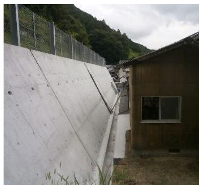
急傾斜地崩壊防止施設 （擁壁工）
