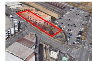
地上の状況（大正川調節池）
