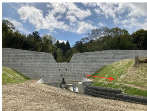
不透過型砂防堰堤
