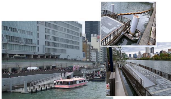
「八軒家浜防災船着場（浮棧橋）」
