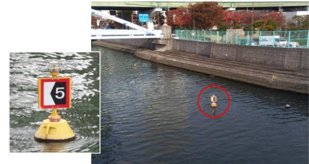
灯浮標（堂島川）
