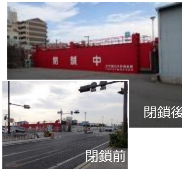
神崎川左門橋左岸鉄扉 (コンクリート部等)
