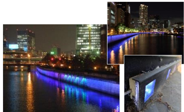
護岸照明施設（大川、堂島川）
