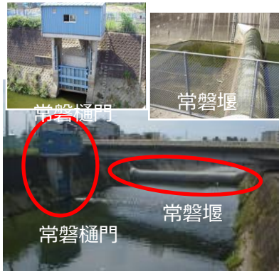
西除川常磐堰・常磐樋門 (堰柱、門柱等のコンクリート部等)
