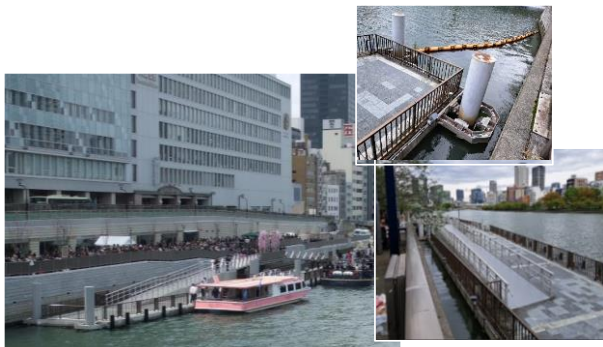
「八軒家浜防災船着場（浮棧橋）」
