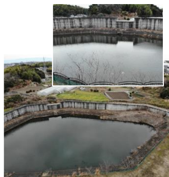
住吉川防災調節池
