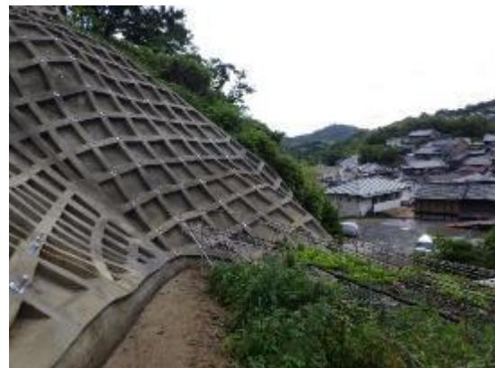
急傾斜地崩壊防止施設 (法枠工)
