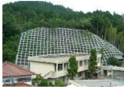
急傾斜地崩壊防止施設
