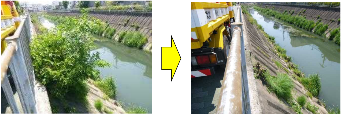
図 3.1-37 直営作業による雑木の伐採
