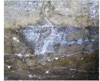
ASR（今川立坑）
