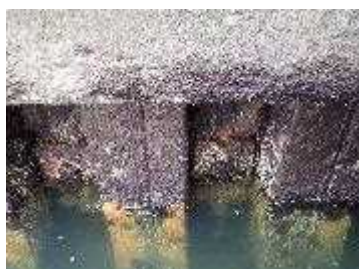
鋼材の腐食
