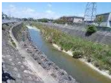
護岸（特殊堤を除く）
