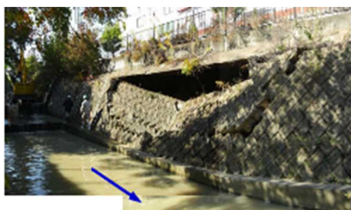
図 3.1-5 護岸の崩壊
