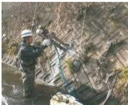
図 3.1-10 コアボーリング、カメラによる空洞化調査
