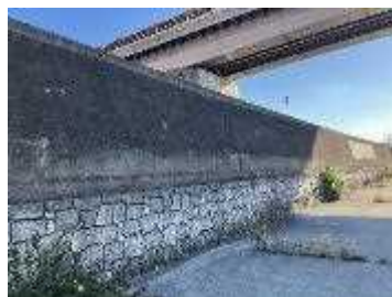
特殊堤（コンクリート）
