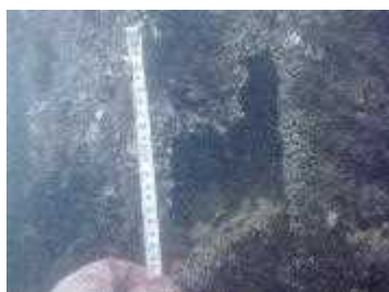
鋼材の貫通孔（水中部）
