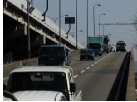
写真 3.1-1 交通量の多い橋梁
