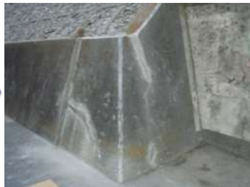
クラック補修（早強モルタル注入）
