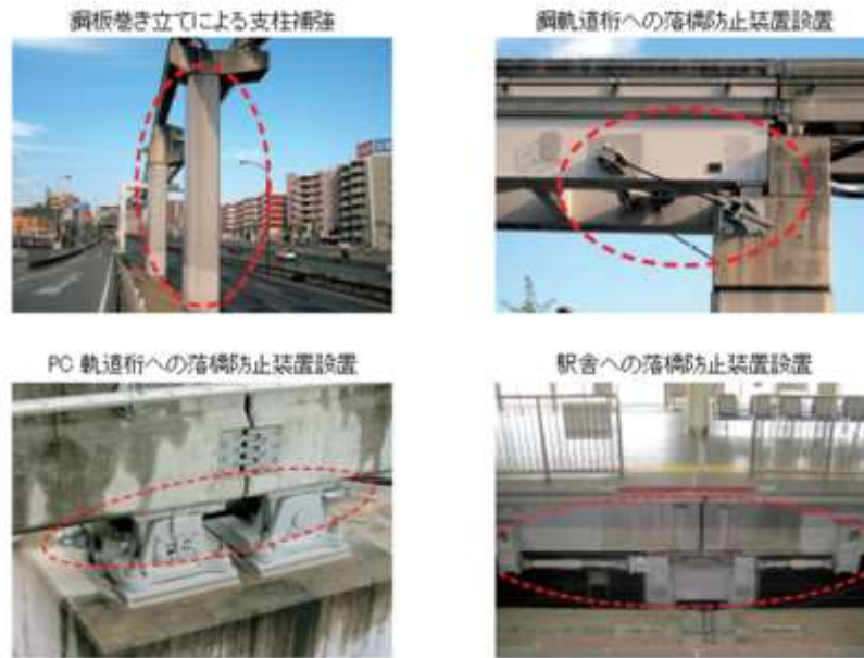
写真 2.2-1 大阪モノレールの耐震補強実施箇所
