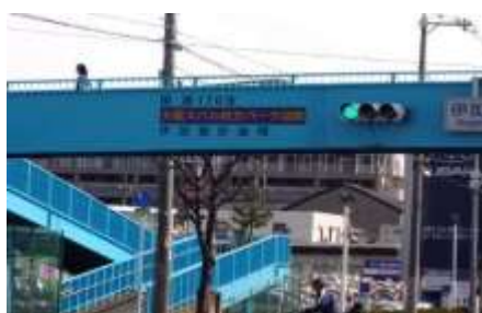
写真 3.1-8 歩道橋ネーミングライツ事例
