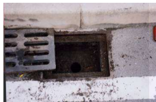
《目詰まり除去後の様子》
