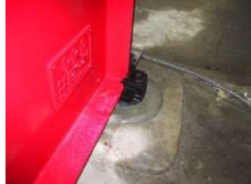
《支承まわりの土砂除去の様子》
