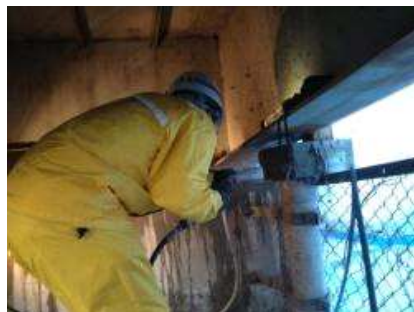
写真 3.1-7 支承のグリスアップ
