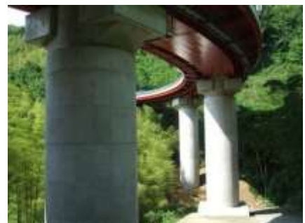
写真 3.1-6 耐震補強(橋脚)
