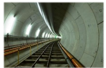
本体工事(下水道増補幹線)
