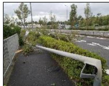
道路照明灯の倒壊(H30台風21号)
