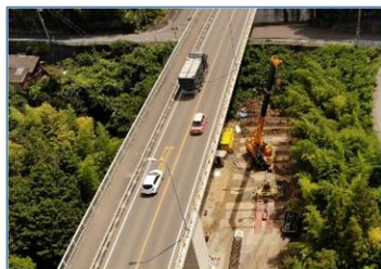
国道170号 (4車線化)
