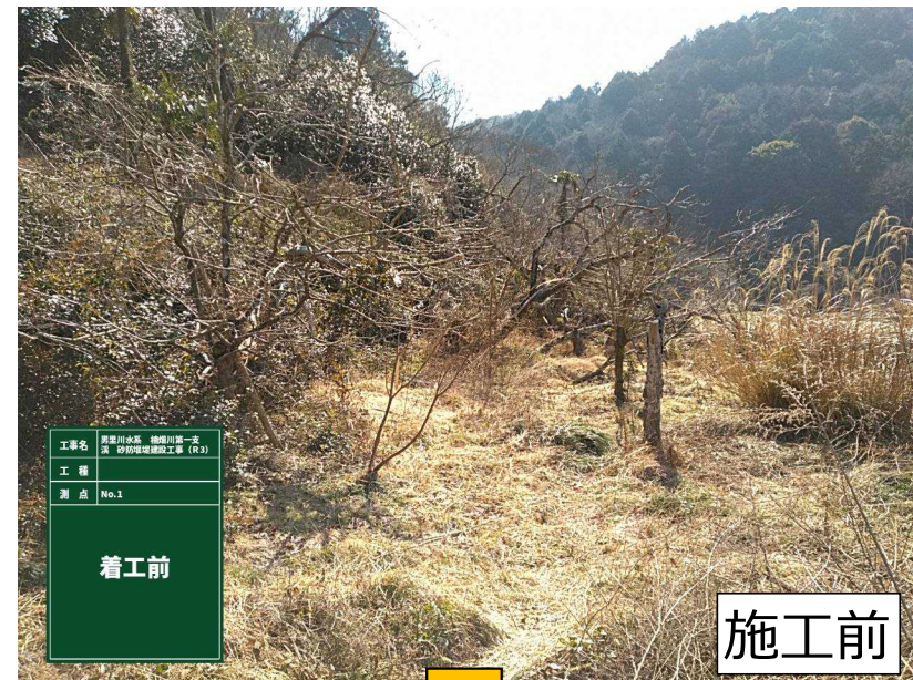
楠畑川第1支溪砂防堰堤 (工事用進入路) (泉南市域)
