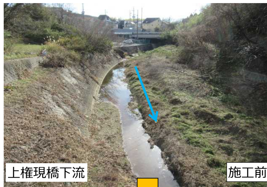
津田川堆積土砂撤去 (岸和田市域)
