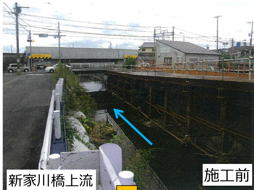
新家川改修 (泉南市域)
