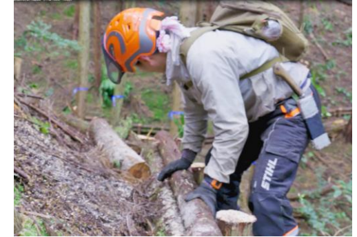
間伐材を利用した筋工
