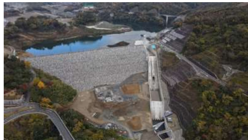
安威川ダム建設事業 (茨木市)
