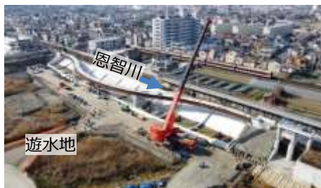
恩智川(法善寺)多目的遊水地 (柏原市)
