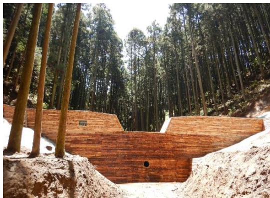
治山ダムの整備
