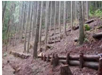
本数調整伐と筋工の施工
