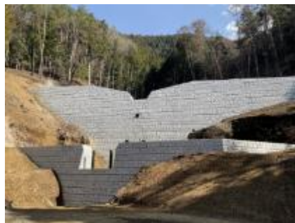
治山ダム(流域治水対策型)の設置
