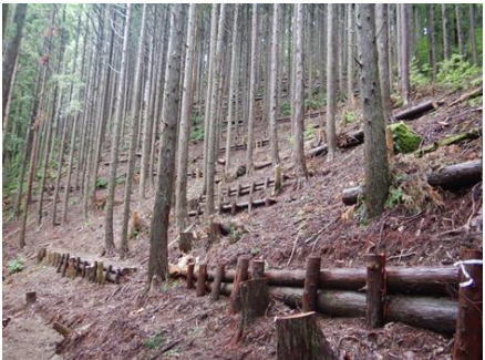
本数調整伐と筋工の施工
