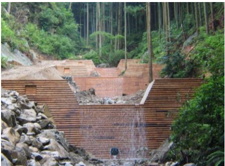
小規模治山ダムの階段状配置
