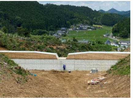
堆砂容量のある治山ダムの設置
