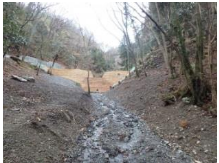
溪流沿いの危険木の除去
