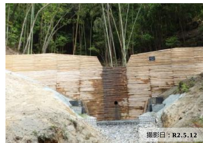
写真② 治山ダム（コンクリート）流木対策の実施状況
