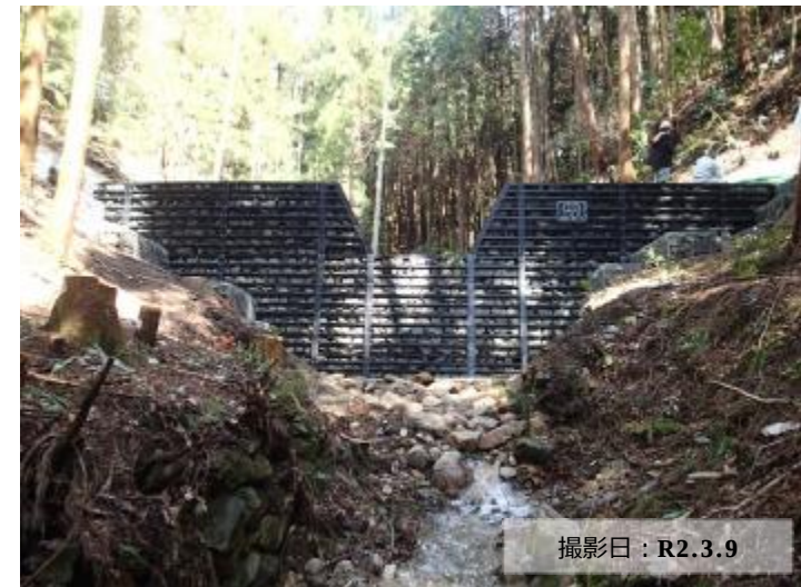
写真② 治山ダム（鋼製）の完了状況
