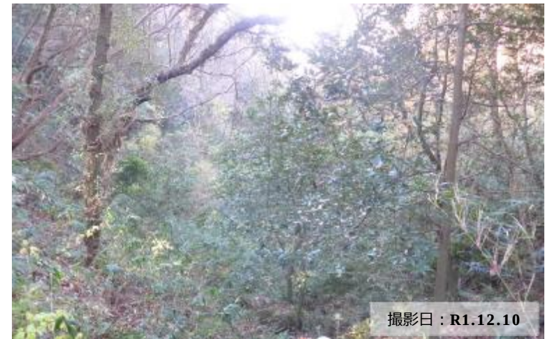
写真① 流木対策施工前 (倒木、枯損木等の状況)
