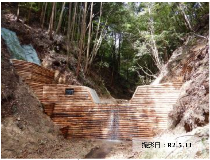
写真①治山ダム（コンクリート）の設置状況
