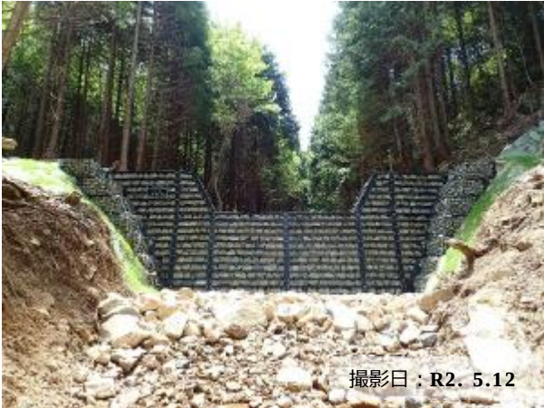
写真① 治山ダム（鋼製）の設置状況
