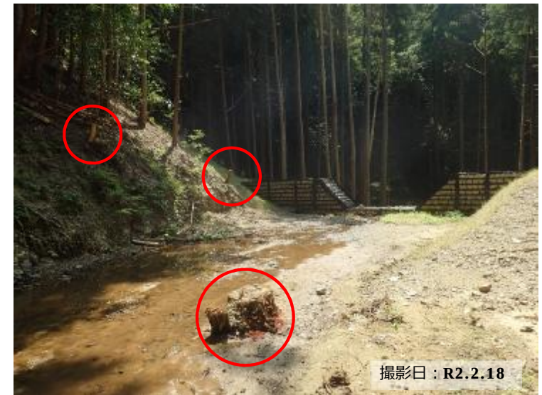
写真② 流木対策の完了状況
