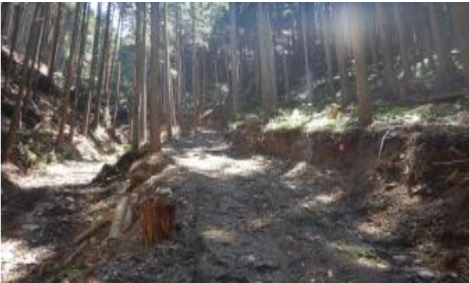
①路面工 (施工前)
