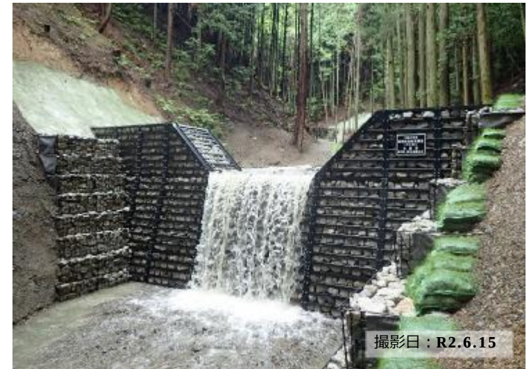
写真① 治山ダム（鋼製）の設置状況
