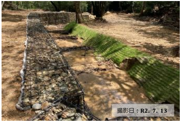
写真② 護岸工の設置状況
