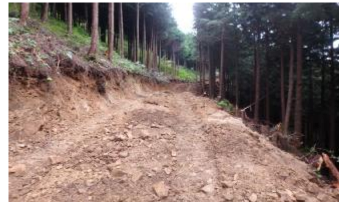
①路面工 (施工前)
