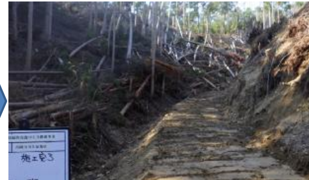
（施工中）支障木の除去
