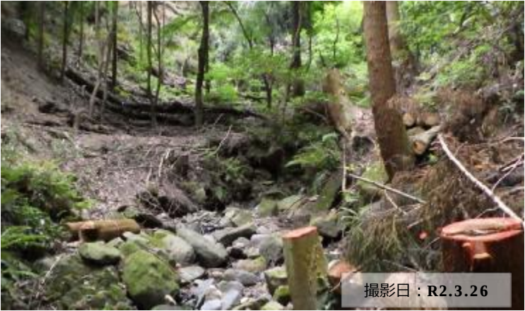
写真② 流木対策の完了状況
