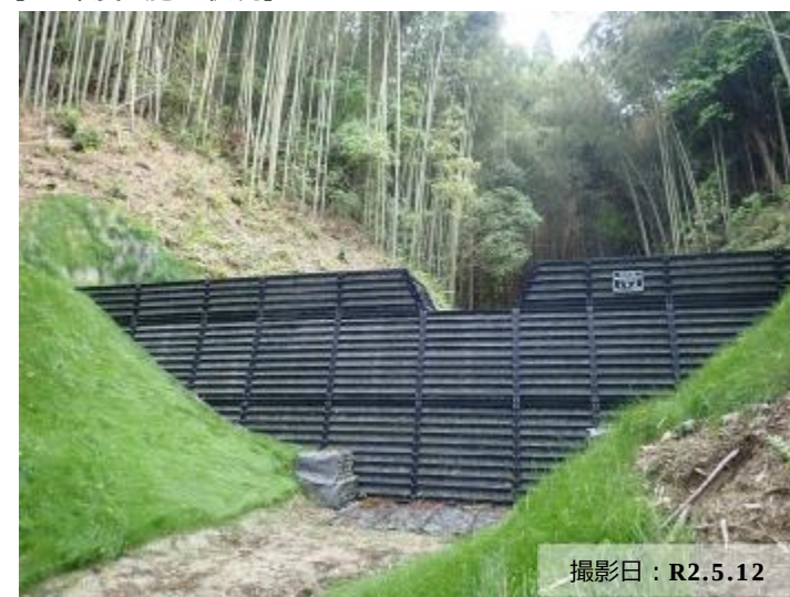
写真① 治山ダム（鋼製）の設置状況
