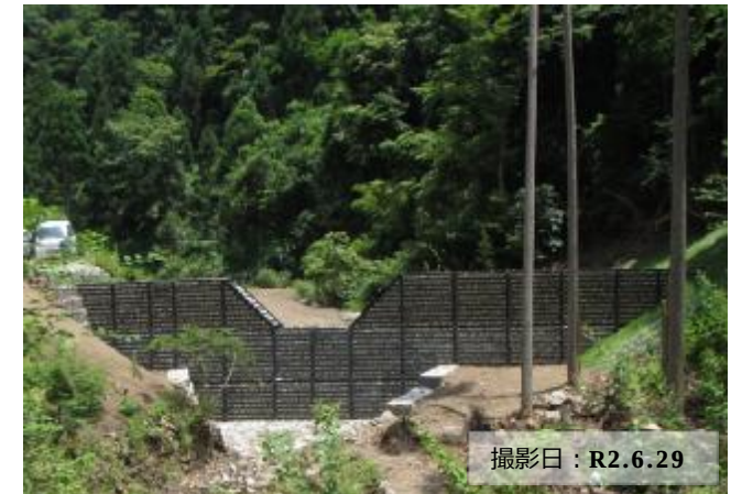
写真① 治山ダム（鋼製）設置状況
