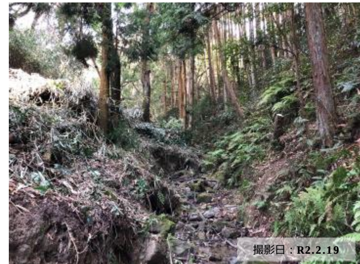
写真② 流木対策の完了状況
