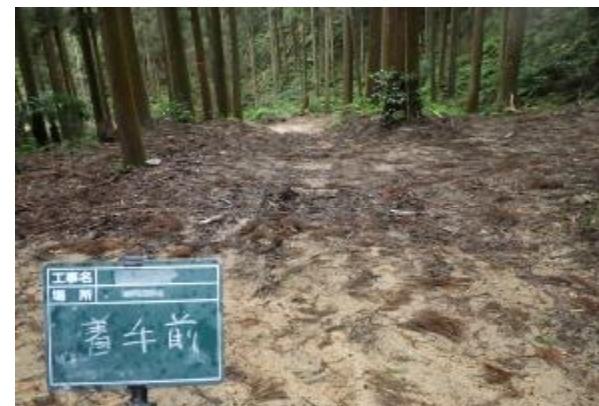
①路面工 (施工前)
