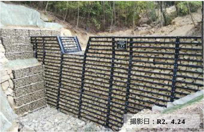
写真① 治山ダム（鋼製）の設置状況
