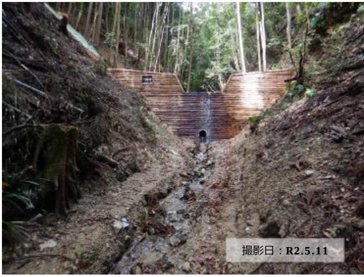
写真② 流木対策の完了状況
