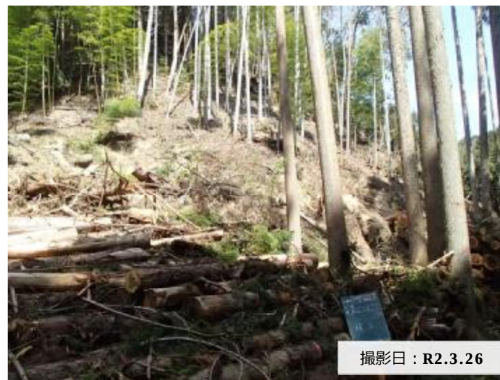
写真① 森林整備（被害木整理）の完了状況
