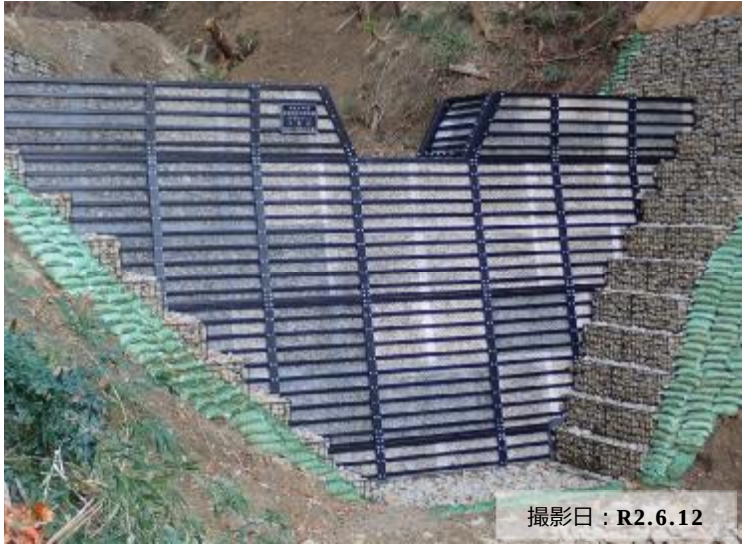
写真① 治山ダム（鋼製）設置状況
