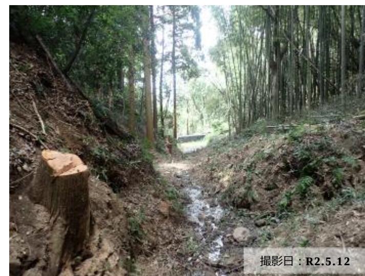
写真② 流木対策の実施状況
