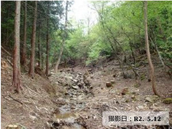
写真② 流木対策の完了状況
