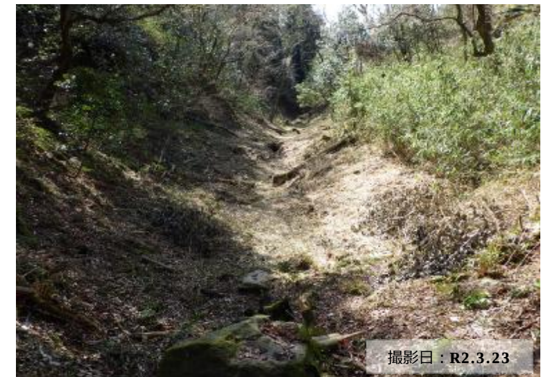
写真② 流木対策の完了状況
