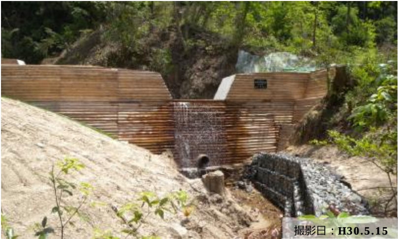
写真① 治山ダム（コンクリート）の設置状況
