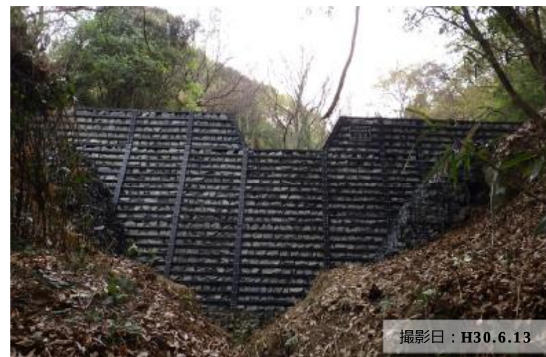
写真② 治山ダム（鋼製）の設置状況
