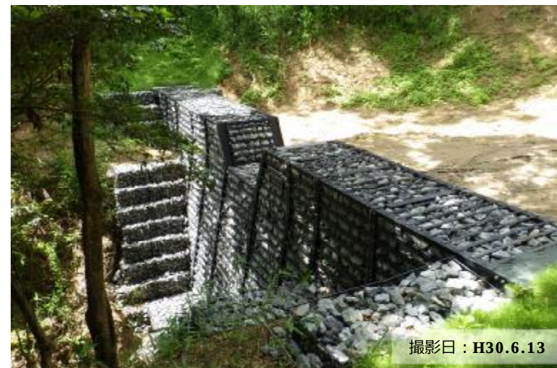
写真① 治山ダム（鋼製）の設置状況
