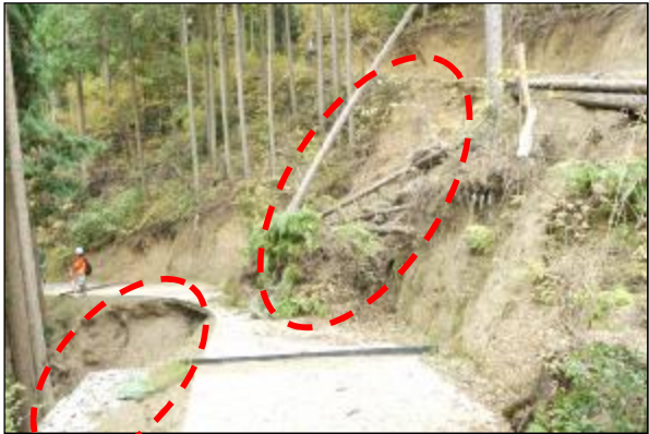
①かご粹工 (施工前)
