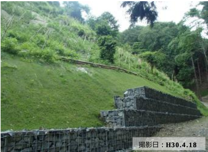
写真② 土留工と森林整備（植栽工）の状況
