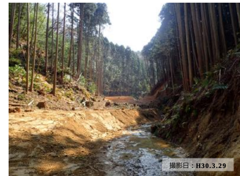
写真② 溪流内の危険木を除去した状況（溪流沿いは強度伐採）
