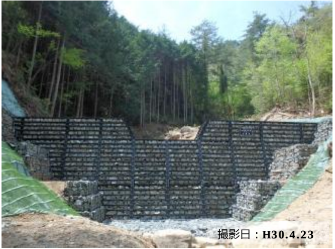
写真① 治山ダム（鋼製）の設置状況
