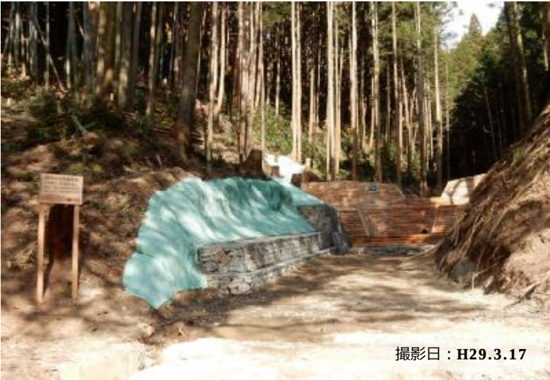
写真① 治山ダム及び流路工（コンクリート）の竣工時の状況
