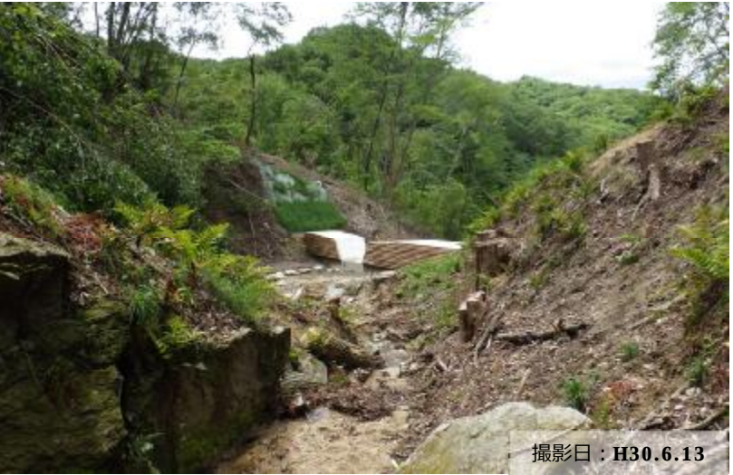
写真② 溪流内の危険木を除去した状況（溪流沿いは強度伐採）
