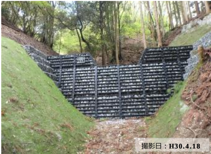
写真① 治山ダム（鋼製）の設置状況
