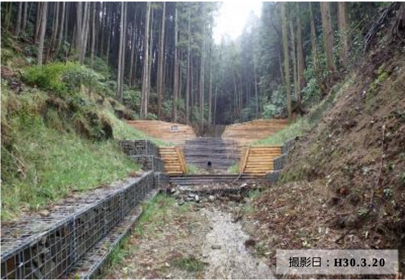
写真① 治山ダム及び流路工（コンクリート）の現況
