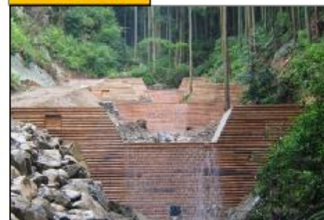
治山ダムの設置により、溪流勾配を 緩和し土石流の発生を未然に防止(千早赤阪村)
