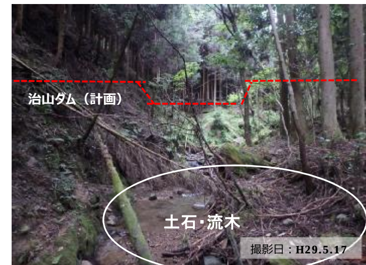
写真② 溪岸侵食を受けた溪流と倒木の状況
