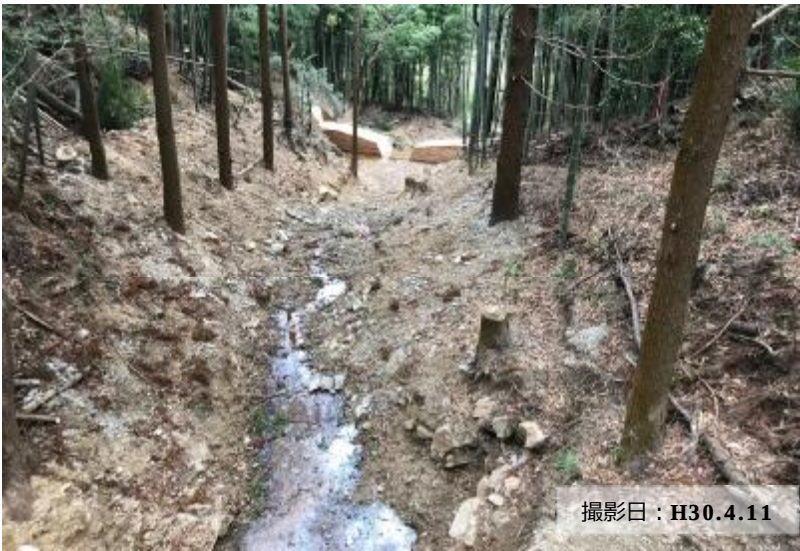
写真② 溪流内の危険木を除去した状況（渓治いは強度伐採）
