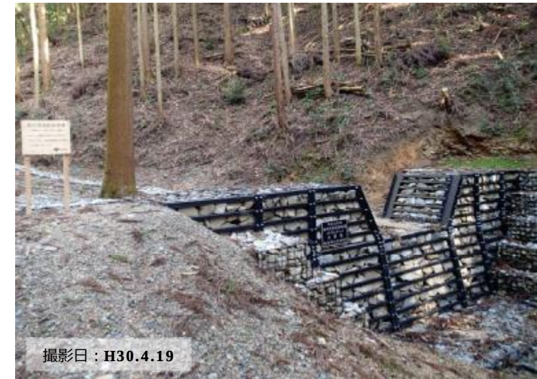
写真① 治山ダム（鋼製）の設置状況
