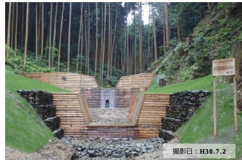
写真② 治山ダム (コンクリート) の設置状況
