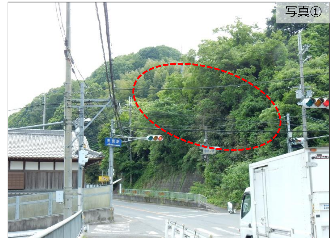
国道371号線沿いの竹林の状況
