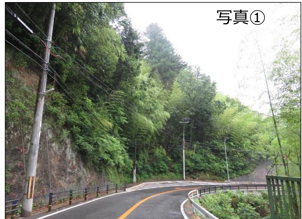
侵入竹により道路背面の森林の荒廃が進行している
