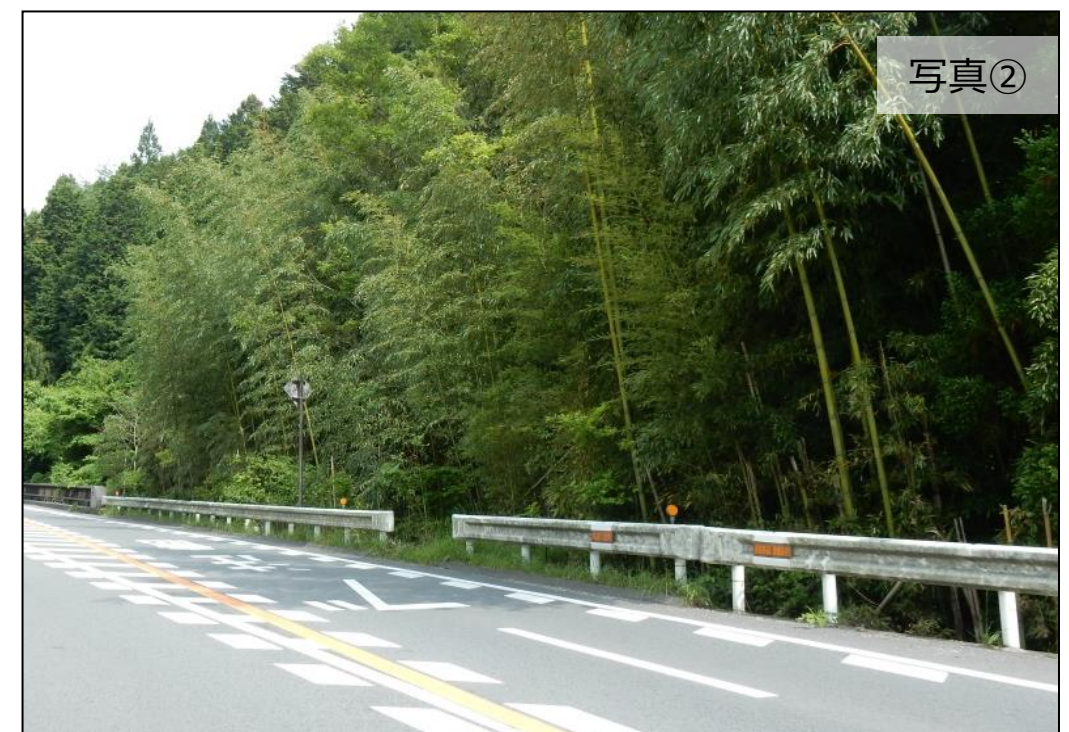
倒伏等による道路の通行障害が危惧される
