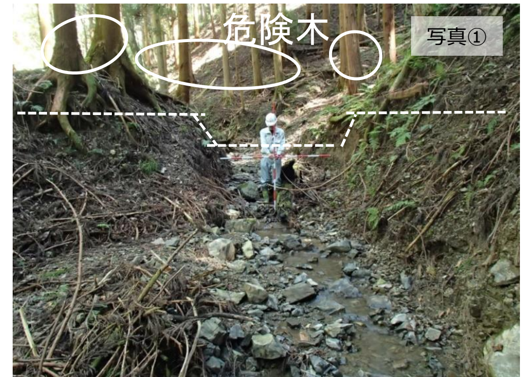
溪流沿いの崩壊地と堆積する流木
