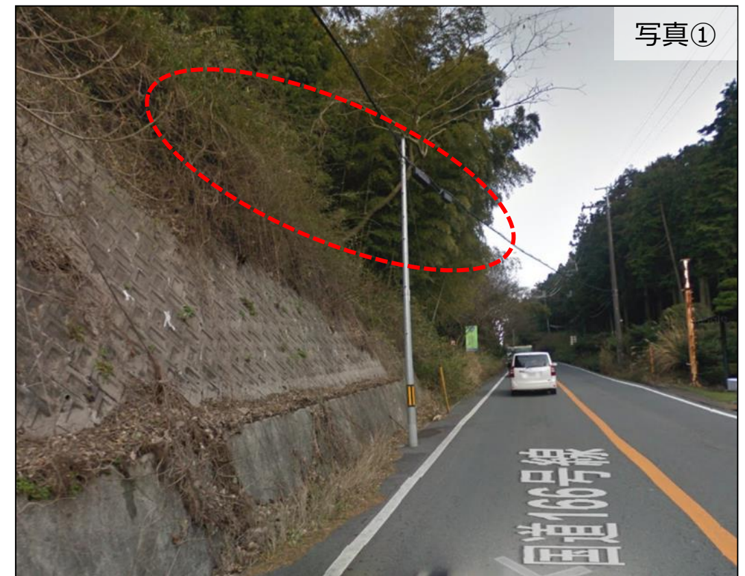
国道166号線沿いの竹林の状況
