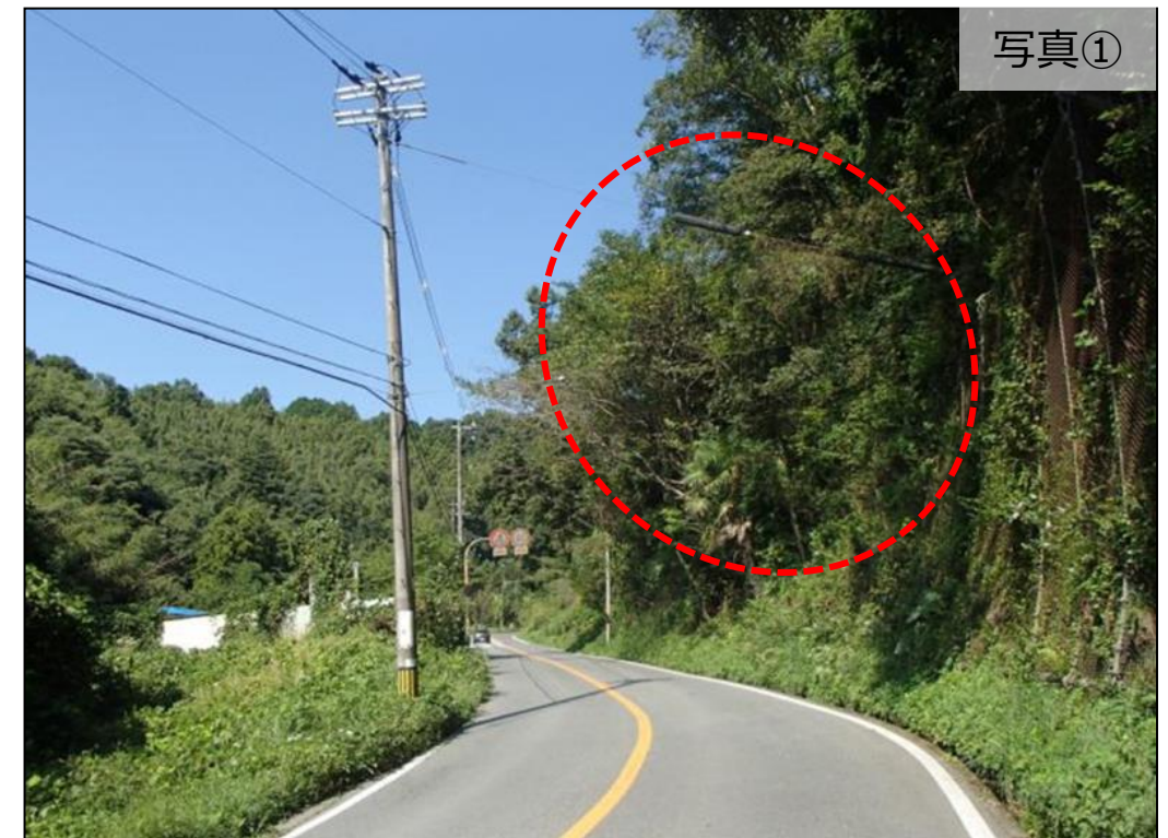
国道309号線沿いの竹林の状況
