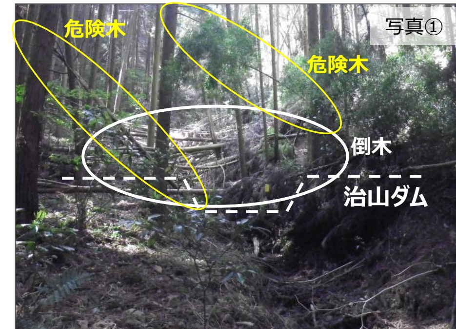
治山ダム整備予定箇所の現況と倒木・危険木
