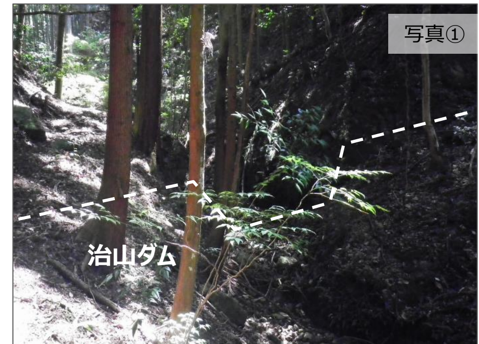
治山ダム整備予定箇所の現況
