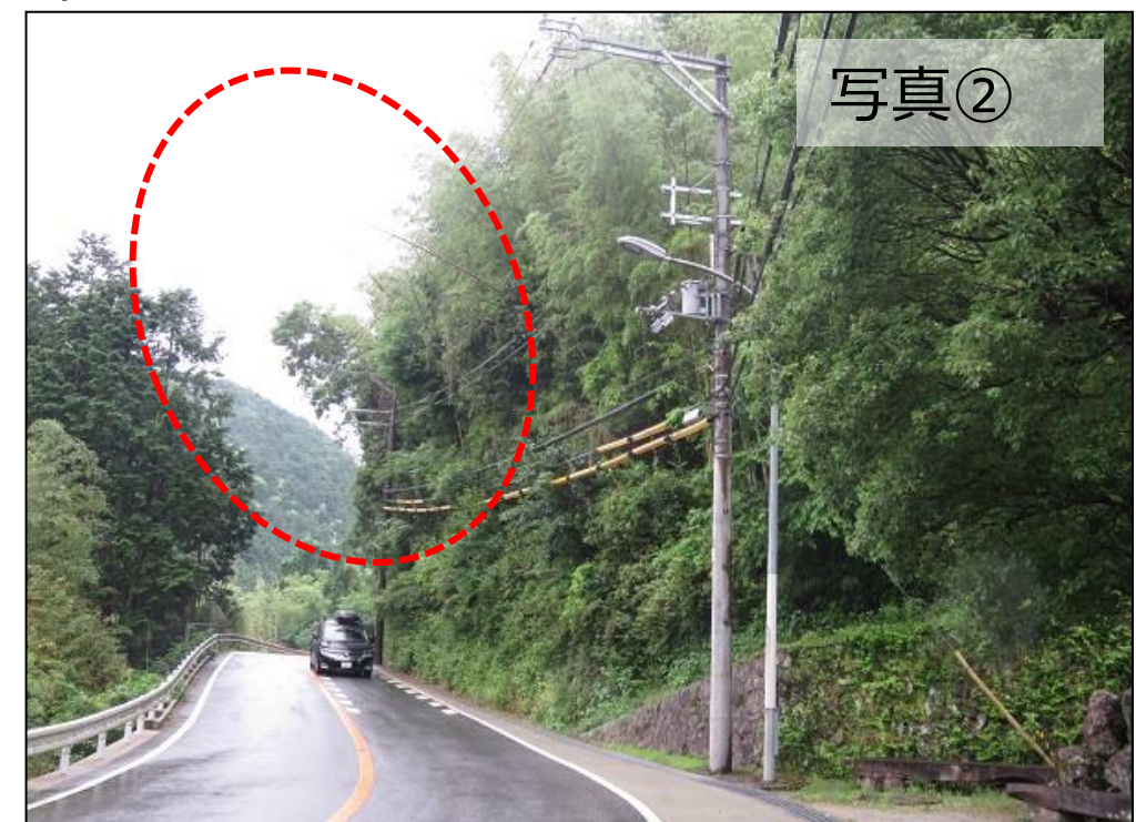
不安定な樹木の倒伏や侵入竹による森林の荒廃が危惧される
