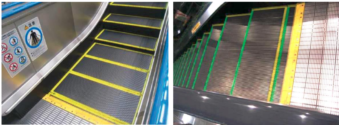
図 7.4 四方を縁取りすることで、踏み段の範囲を視認しやすくしている例
