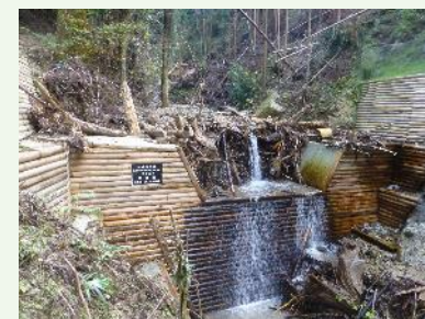
治山ダムによる 土砂・流木の捕捉
