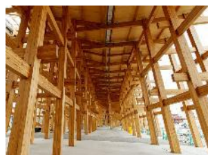
CLT材の使用と伝統工法の貫接合と現代工法の融合等、大型木造建築物への可能性を広げました。
