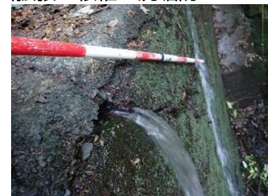
コンクリートの劣化・ひび割れ・漏水
