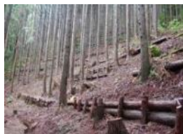
保水力向上のための間伐・筋工
