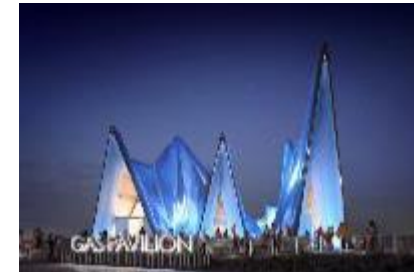
ガスパビリオン外装膜への 放射冷却素材の使用 提供: 日本ガス協会
